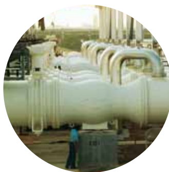
Обратный клапан 72" / ASME 175
