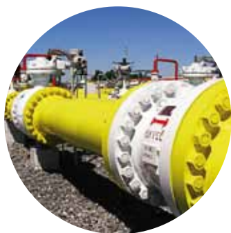
Обратный клапан 20" / ASME 600
