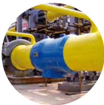
Обратный клапан 20" / ASME 2500
